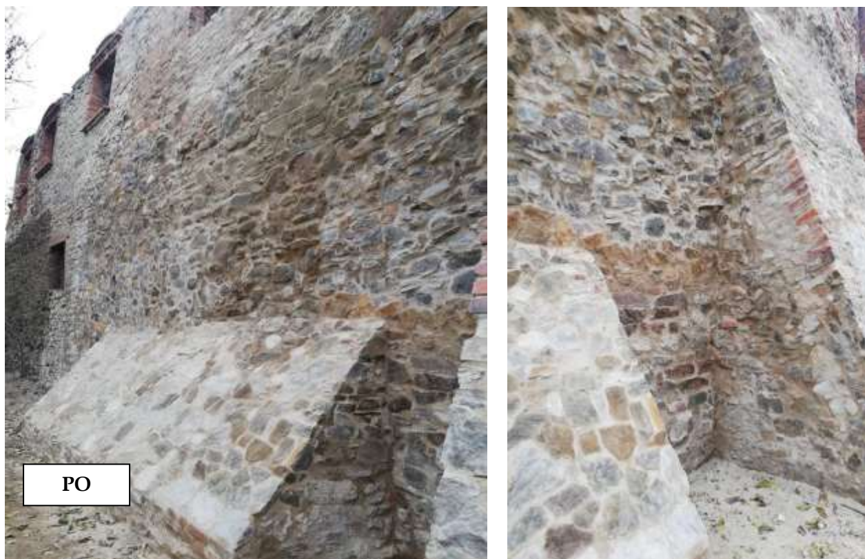
fot. Centrum Kultury „Zamek w Toszku” - fragment naprawionego muru obronnego
