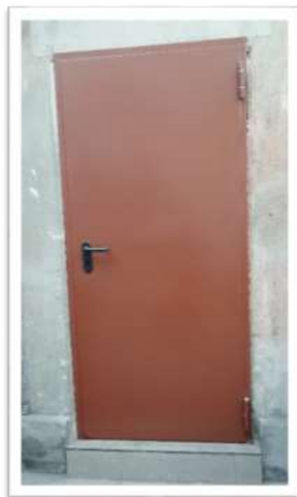
fot. archiwum Urzędu Miejskiego w Toszku – wymienione drzwi zewnętrzne w budynku gospodarczym Urzędu Miejskiego w Toszku
