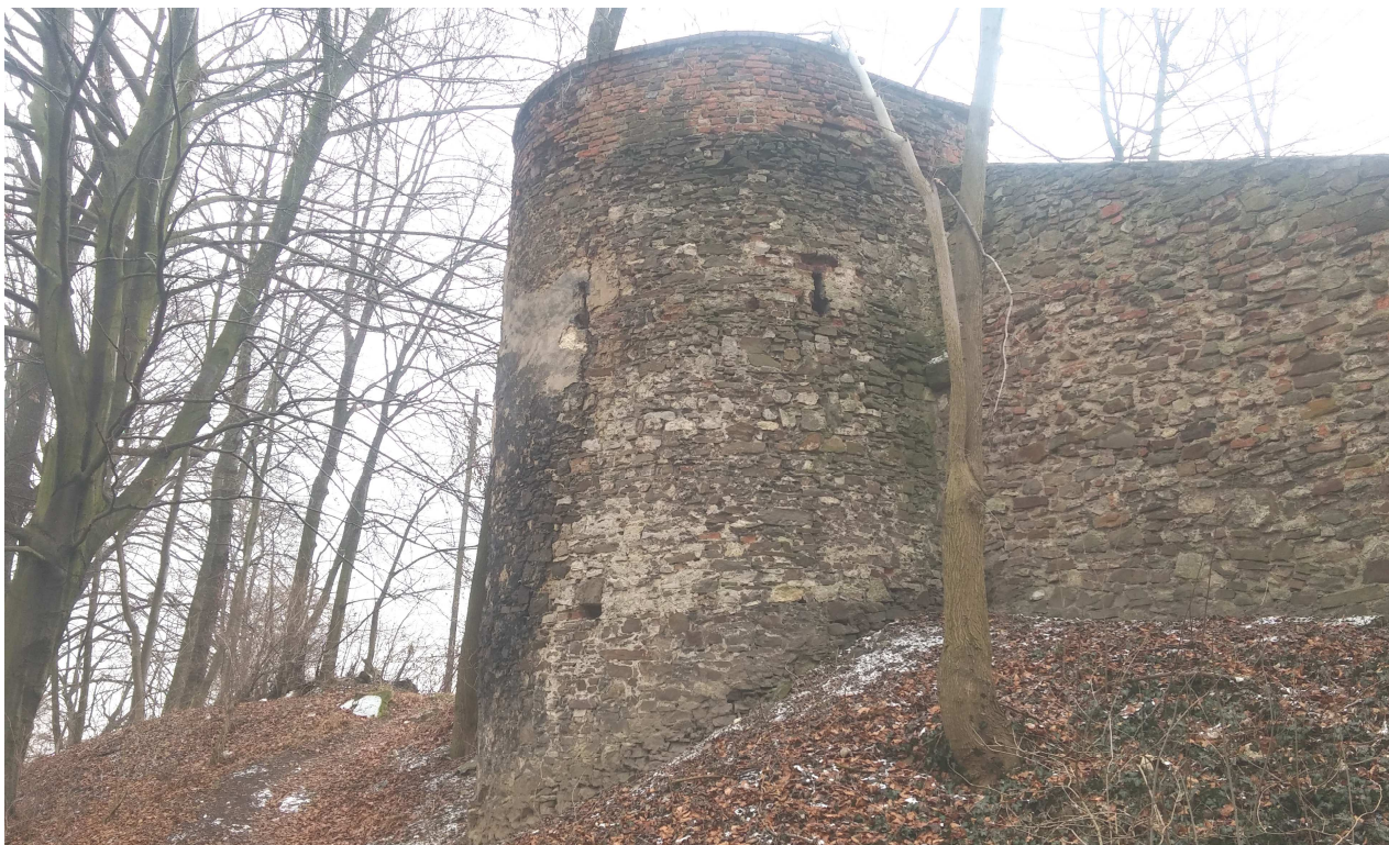
Fot nr 17. Widok bastei od strony skarpy.
