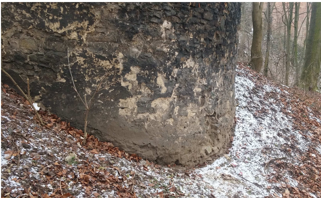
Fot nr 18. Widok bastei od strony skarpy.
