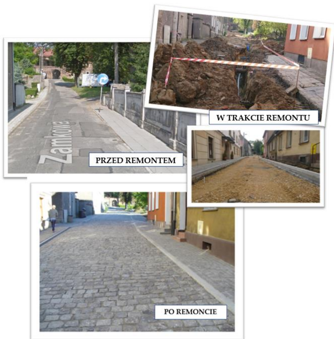
Etapy przebudowy ul. Zamkowej w Toszku
