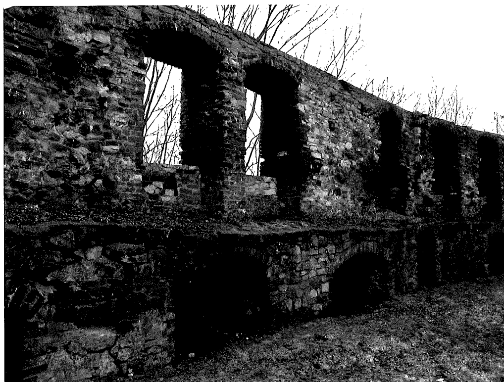
Fot.10. Widok ogólny muru z blendami w dolnej części oraz otworami okiennymi zamkniętymi odcinkowo w górnej.
