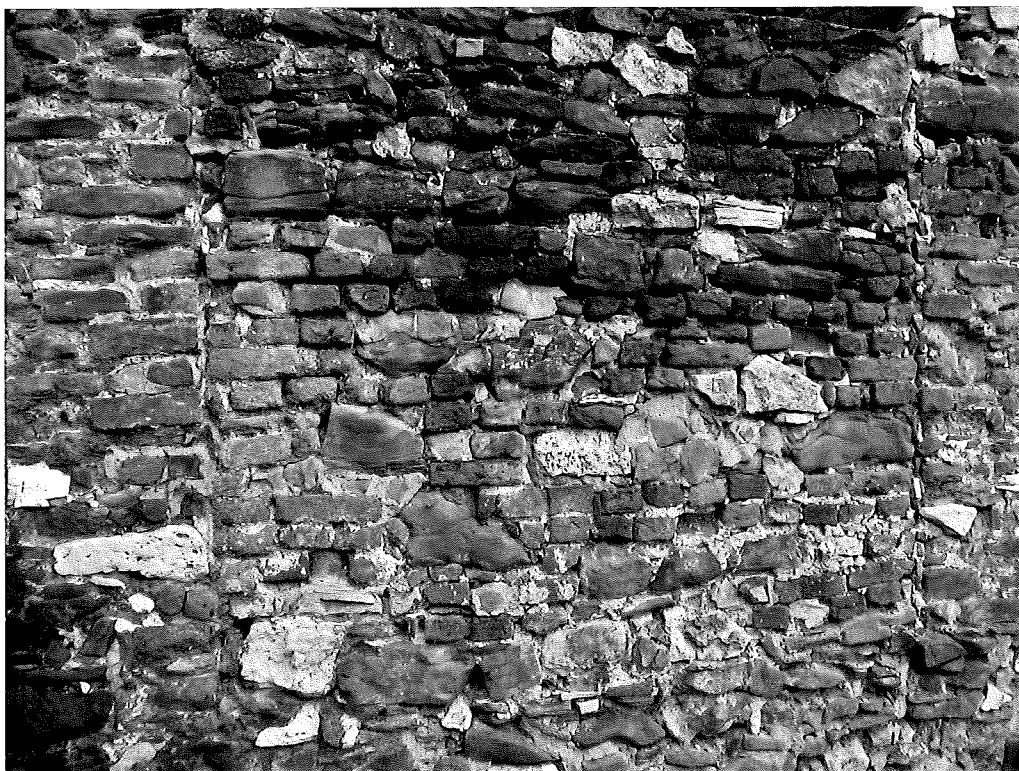
Fot.16. Widok ogólny muru z przemieszaniem materiałowym kamienia oraz cegły.
