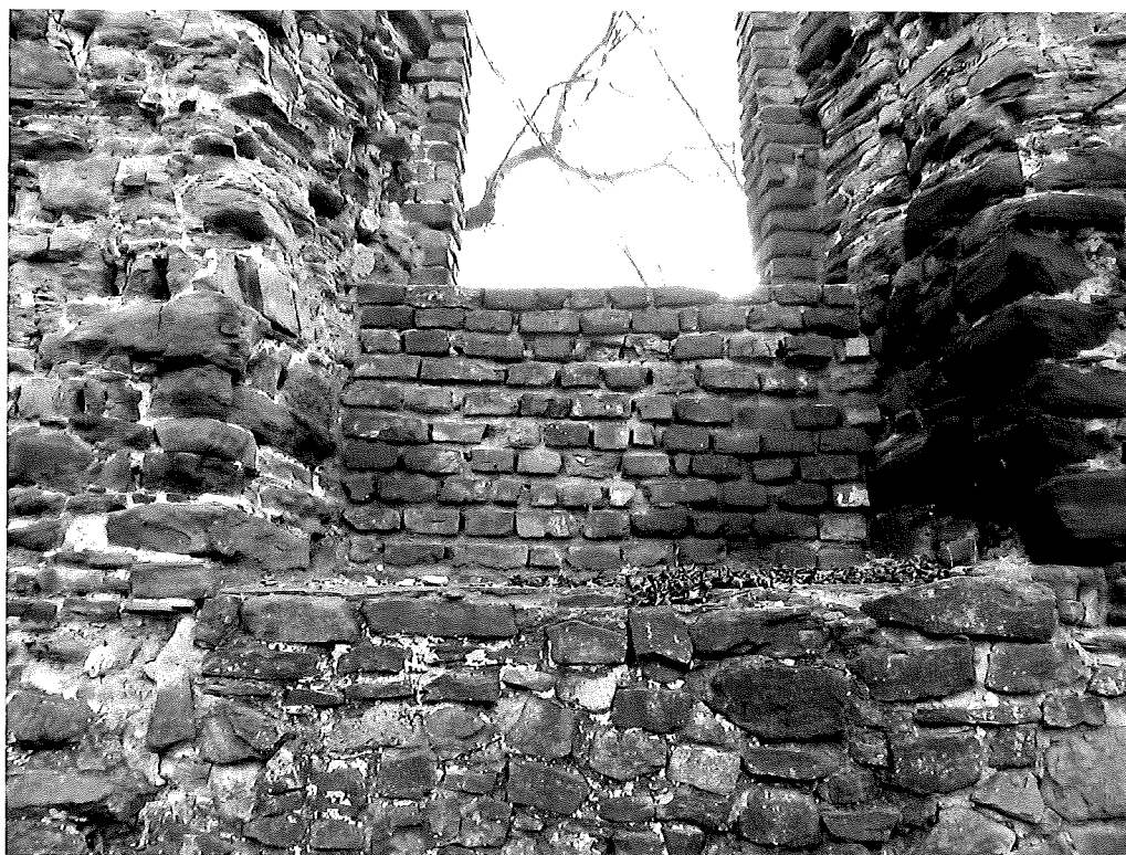
Fot.14. Widok ogólny ceglanej podmurówki pod oknem muru na odcinku G-H.
