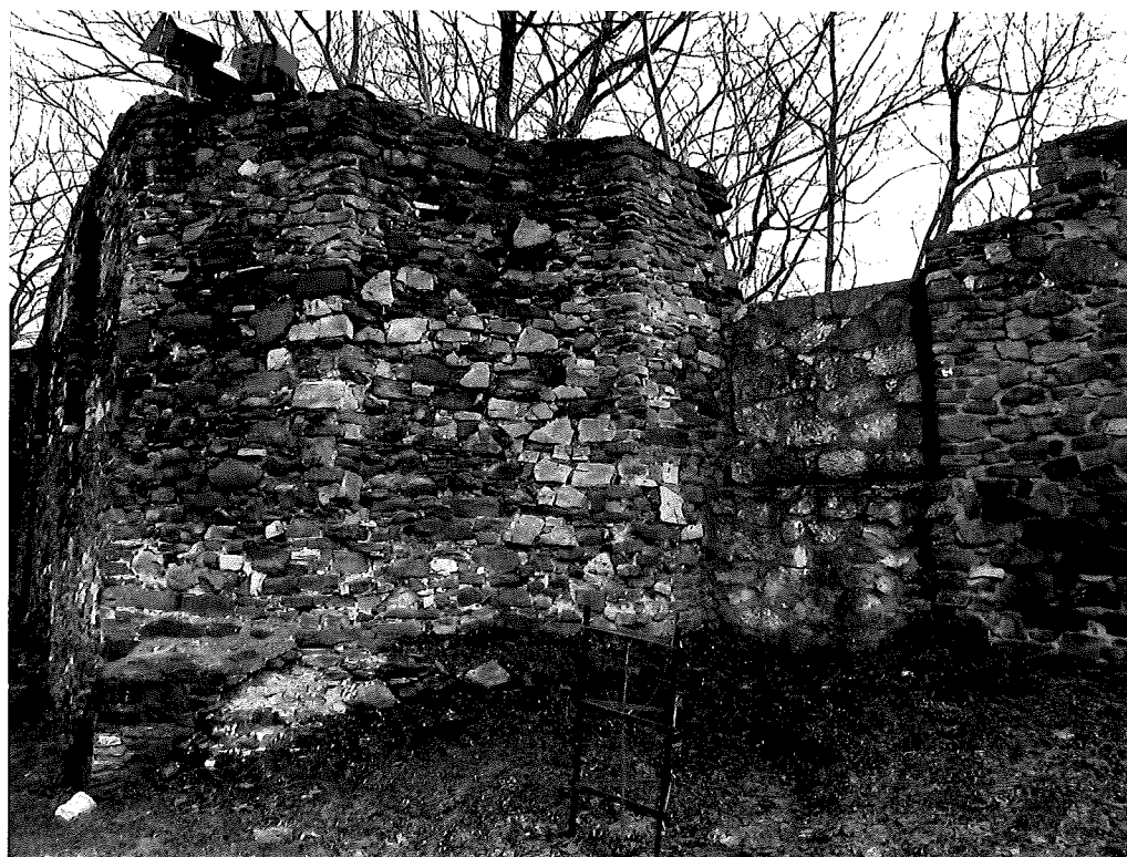
Fot.8. Widok ogólny muru w punkcie H.
