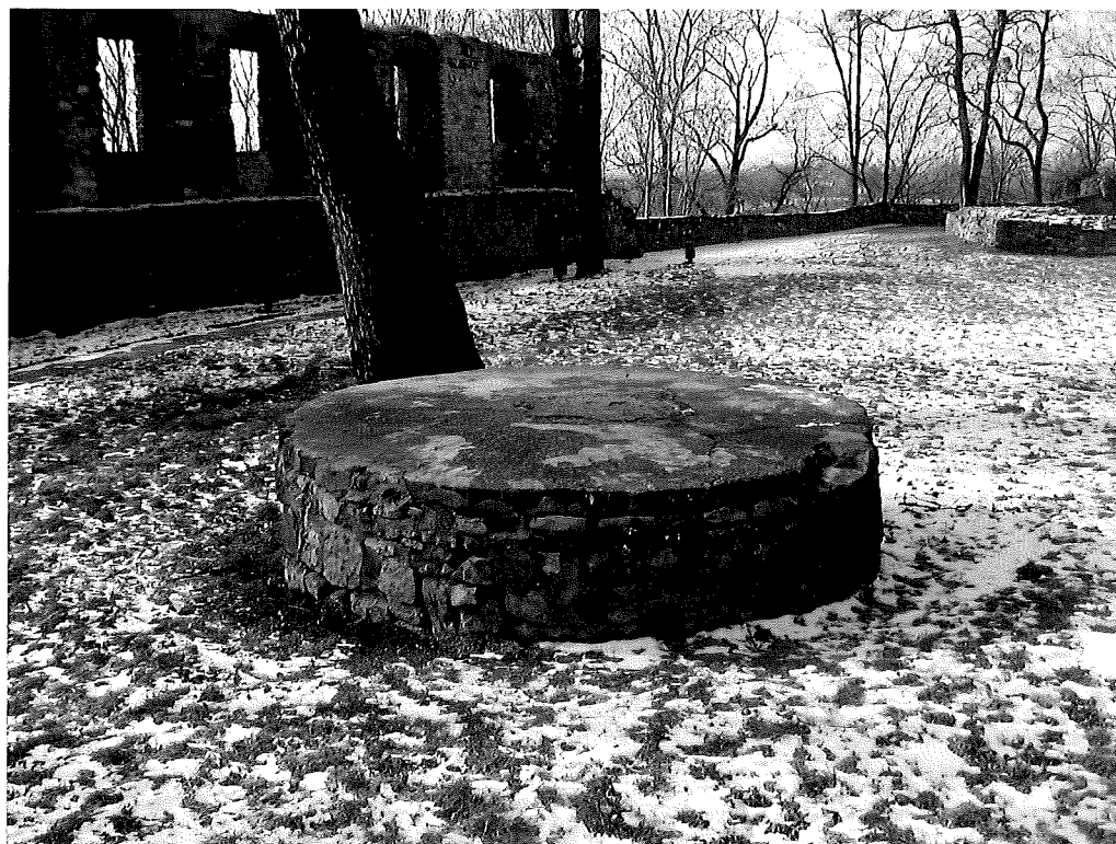
Fot.22. Widok ogólny kamiennej studni umieszczonej na dziedzińcu.
