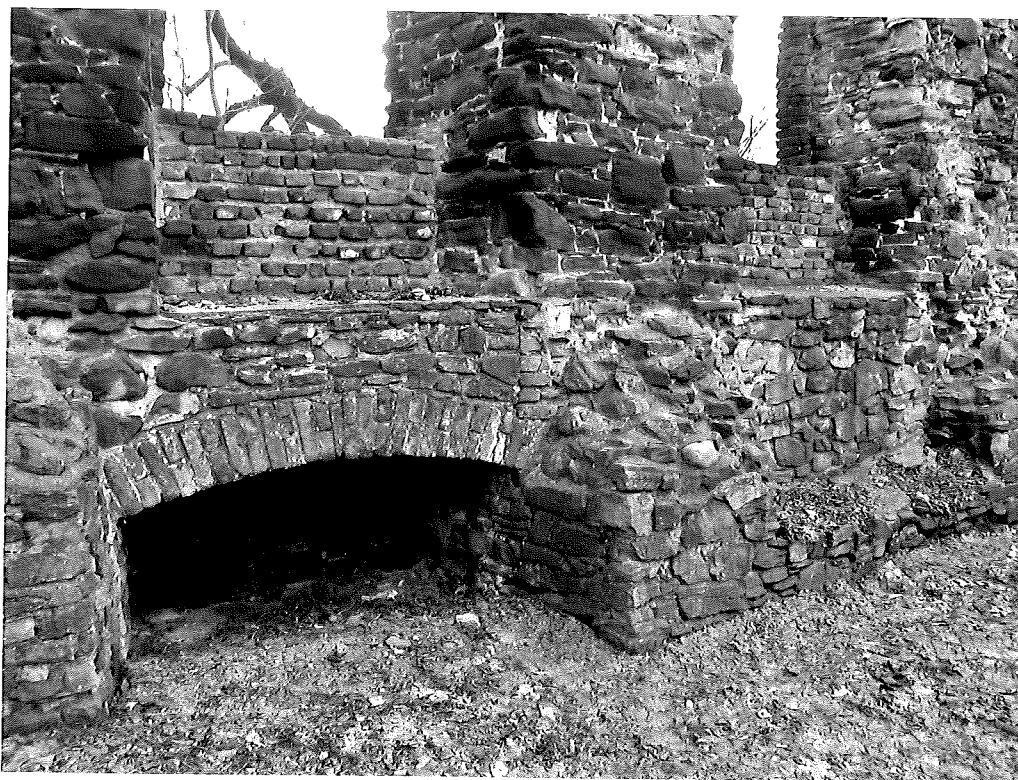
Fot.13. Widok ogólny blendy od góry zamkniętej łukiem odcinkowym, umieszczonej w dolnej części muru.
