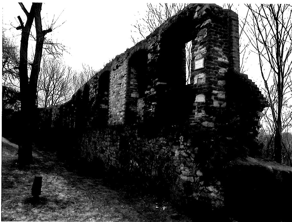
Fot.17. Widok ogólny muru na odcinku G-H.
