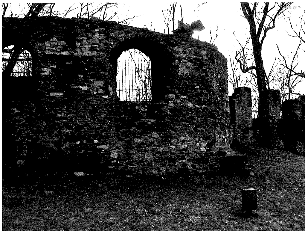
Fot.7. Widok ogólny fragmentu murów na odcinku H-J z łukowymi otworami okiennymi.
