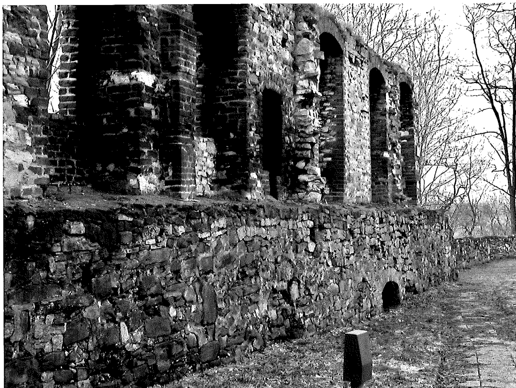
Fot.11. Widok ogólny muru. Dolna część muru wykonana z kamienia znacznie szersza od górnej części wykonanej z cegły i kamienia.
