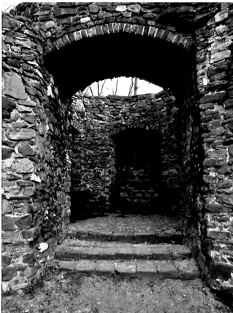
Fot.5. Widok ogólny wejścia prowadzącego do bastieji od góry zamkniętego łukiem odcinkowym.
