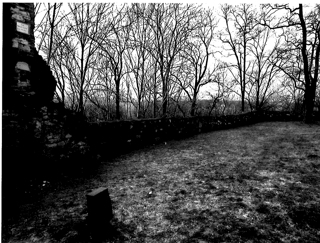
Fot.18. Widok ogólny muru na odcinku E-G. Mur wzniesiony na wysokość ok. 1,00m wykonany z kamienia, dobudowany w trakcie odbudowy zamku.
