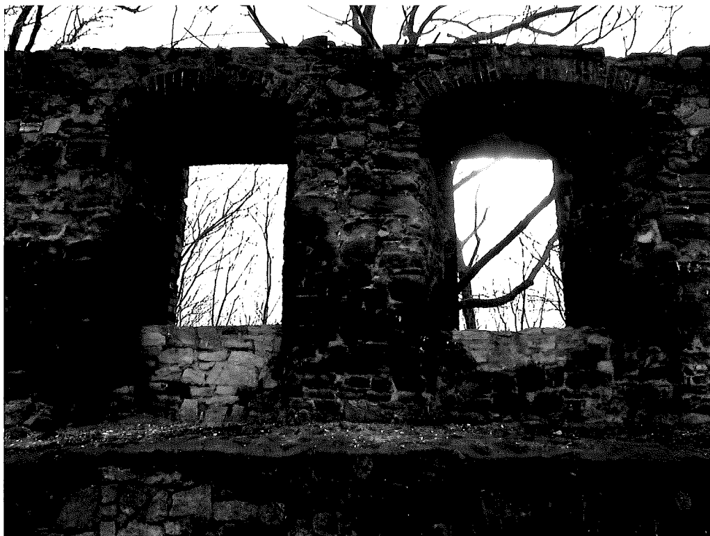
Fot.12. Widok ogólny otworów okiennych zamkniętych odcinkowo.
