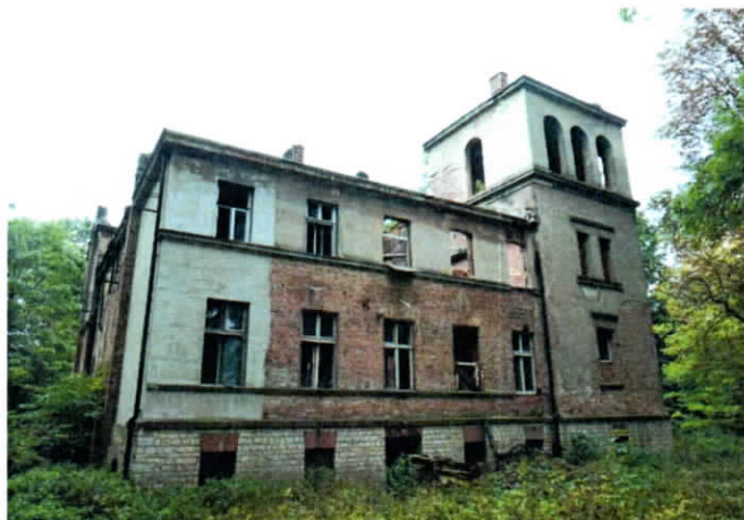
Zdjęcie nr 14. Pałac - Cziworak w Kotliszowicach
