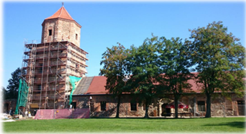
foto. archiwum Urzędu Miejskiego w Toszku – wieża zamkowa w trakcie renowacji
